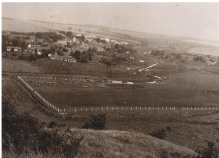
Futbalový areál ešte bez tribúny (vľavo) a už s postavenou tribúnou (vpravo)
