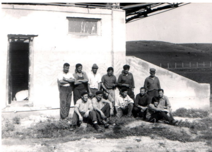
Brigádnici na stavbe tribúny
